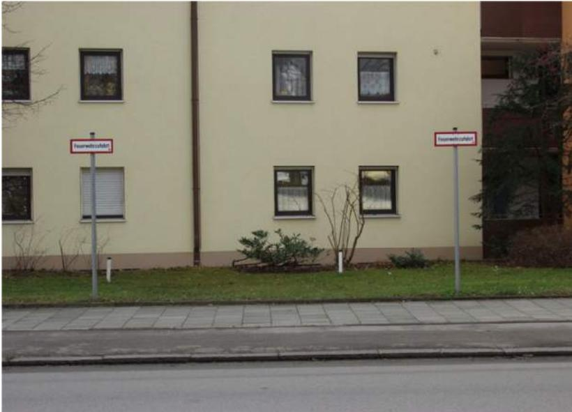
Abb. 11 – Feuerwehzufahrt über Gehweg mit abgesenkten Randstein
